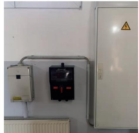
**Notstromeinspeise- und Adaptierungsleitungen und Umschaltvorrichtungen nach DIN 14092 und DIN VDE 0100-551 Beiblatt 1**
