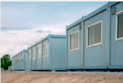
Temporäre Bürocontainer für Drittunternehmen
