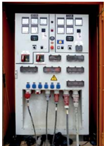
Abb. 14 Anschlussfeld eines Stromerzeugers mit integrierten RCDs
