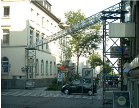
Abb. 1 Hochgelegte Leitung zur Straßenquerung
