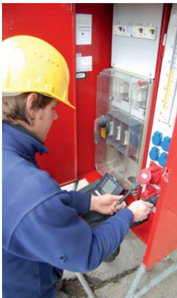
Abb. 10 Inbetriebnahmeprüfung eines Baustrom- verteilers nach VDE 0100-600
