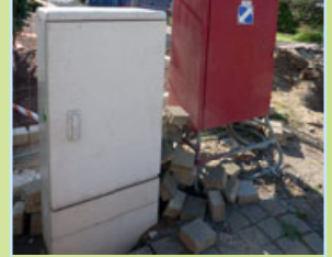
Kabelverteilerschrank
