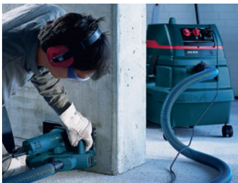
Abb. 14 Mauernutfräse mit Staubabsaugung
