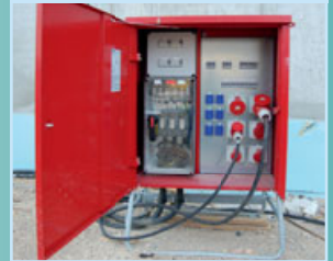
Baustromverteilerschrank
